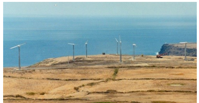
Primeiro Parque Eólico de Figueiral (Santa Maria) 240 kW
