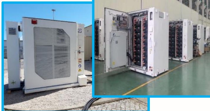
Ensaio em fábrica no Vietnam Ensaio laboratorial no LABELEC
